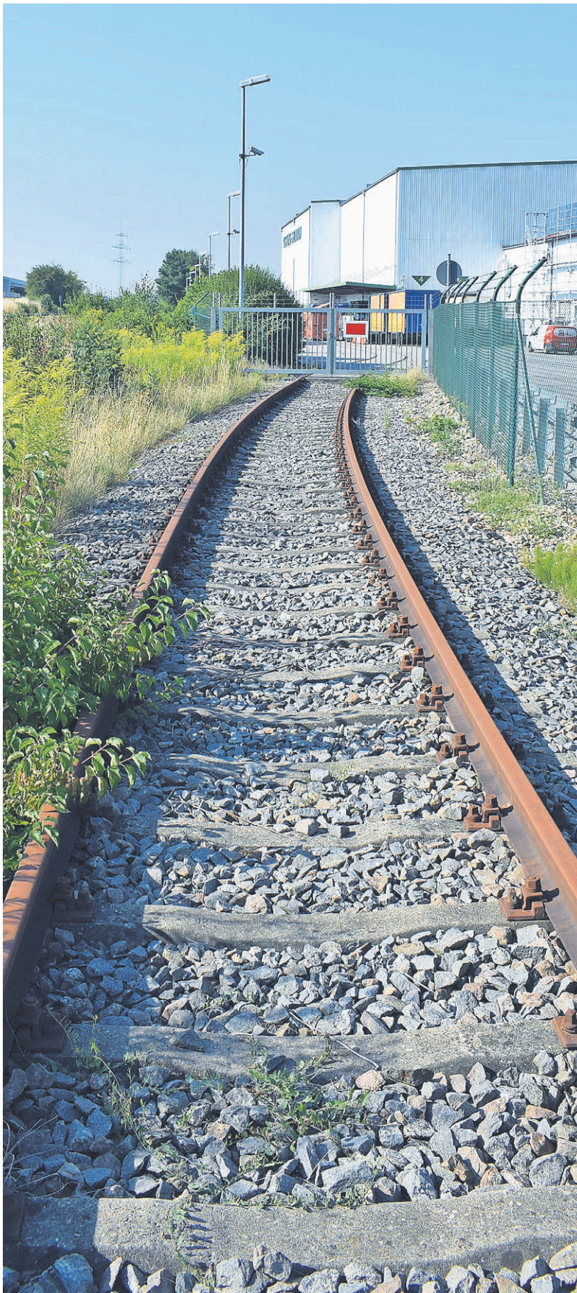
Im Dornröschenschlaf: Bereits 2001 hat die Bahn den Gleisanschluss der Regensstauffer Spedition Kiessling gekündigt. FOTOS: LOEFFLER; WOLF, BERG/DPA
